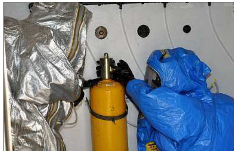
Eine Verschlusskappe wird montiert, um den Chlorgasaustritt zu stoppen.
